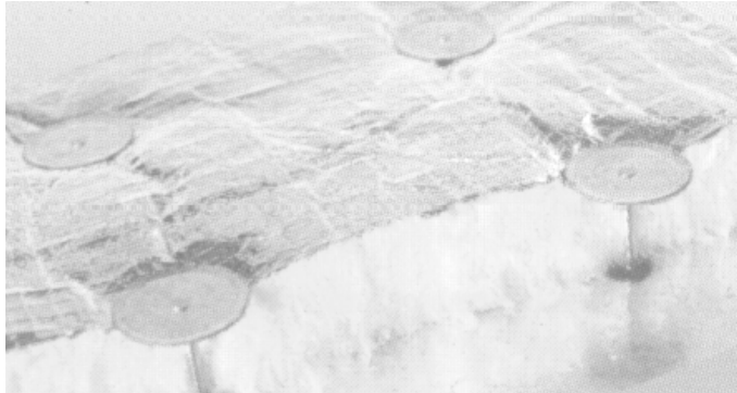
Bild 4: Tellerstifte auf sendzimirverzinktem Blech
