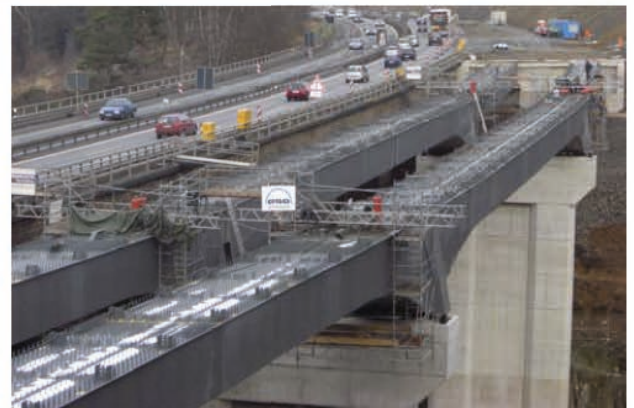
Bild 11: Verbundbrücke Einsiedelstein (BAB A1)
