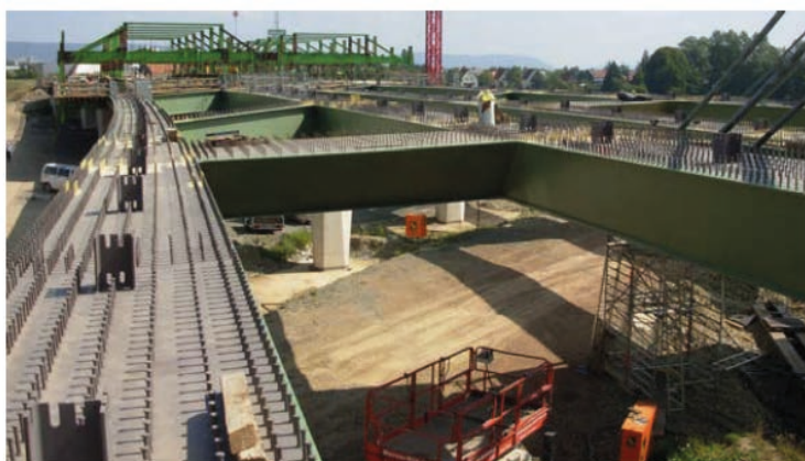
Bild 12: Verbundbrücke bei Bad Oeynhausen
