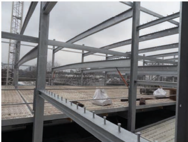
Bilder 3a und 3b: Weitgespannte Verbundträger im Parkhausbau
