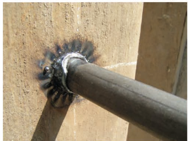
Abbildungen 6 und 7: Kopfbolzen 19 mm Durchmesser, geschweißt an einer Spundwand in Position PC
