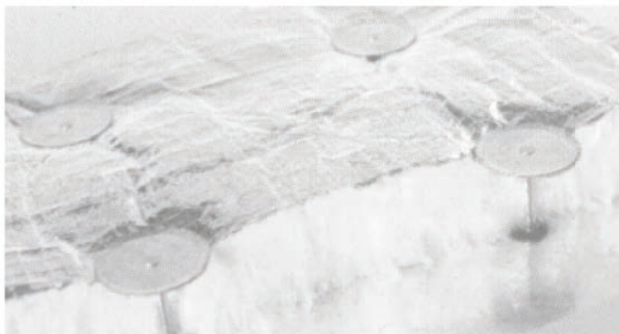
Bild 4: Tellerstifte auf sendzimirverzinktem Blech
